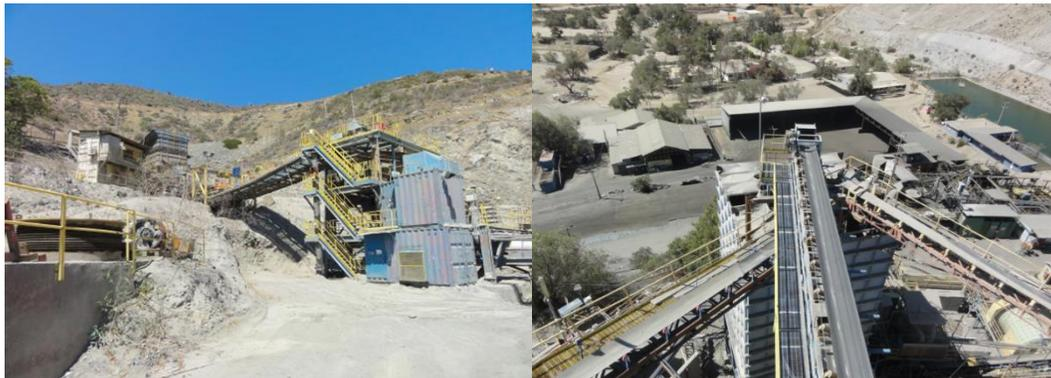
Figura 2. Vista de la cinta que conduce a las tres trituradoras de cono terciarias (izquierda) y a la nave de concentrados de Cinabrio (derecha).
